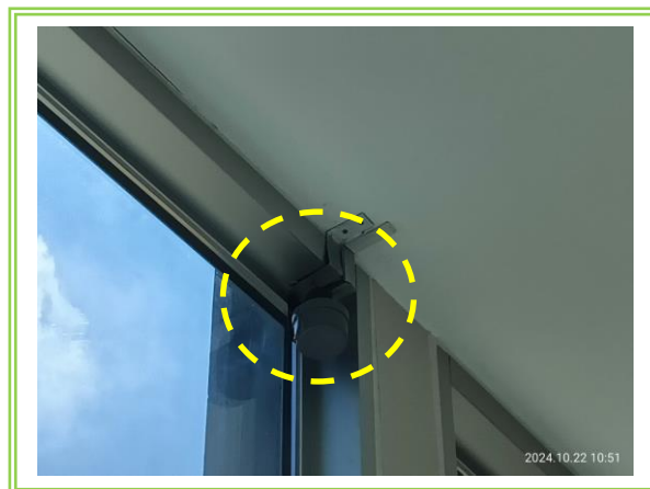
รูปที่ 3-50 ระบบ Light sensor
