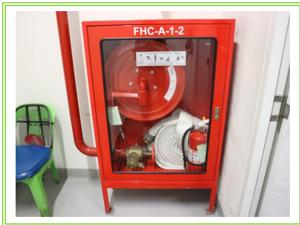
รูปที่ 3-61 ตู้เก็บสายฉีดน้ำดับเพลิงพร้อมอุปกรณ์
