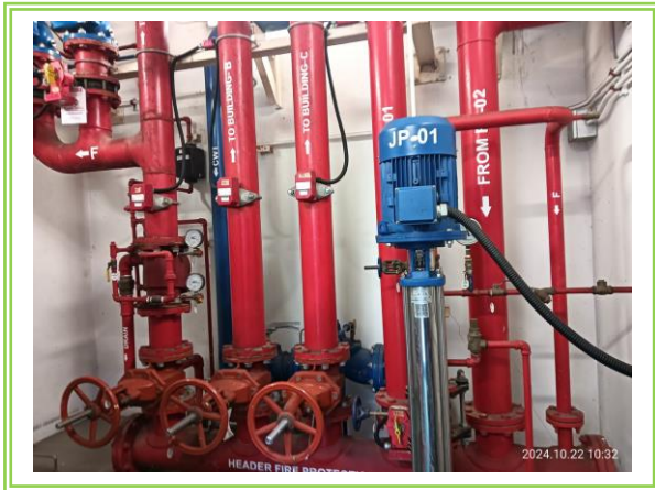
รูปที่ 3-59 ระบบท่อยืน (Stand Pipe)
